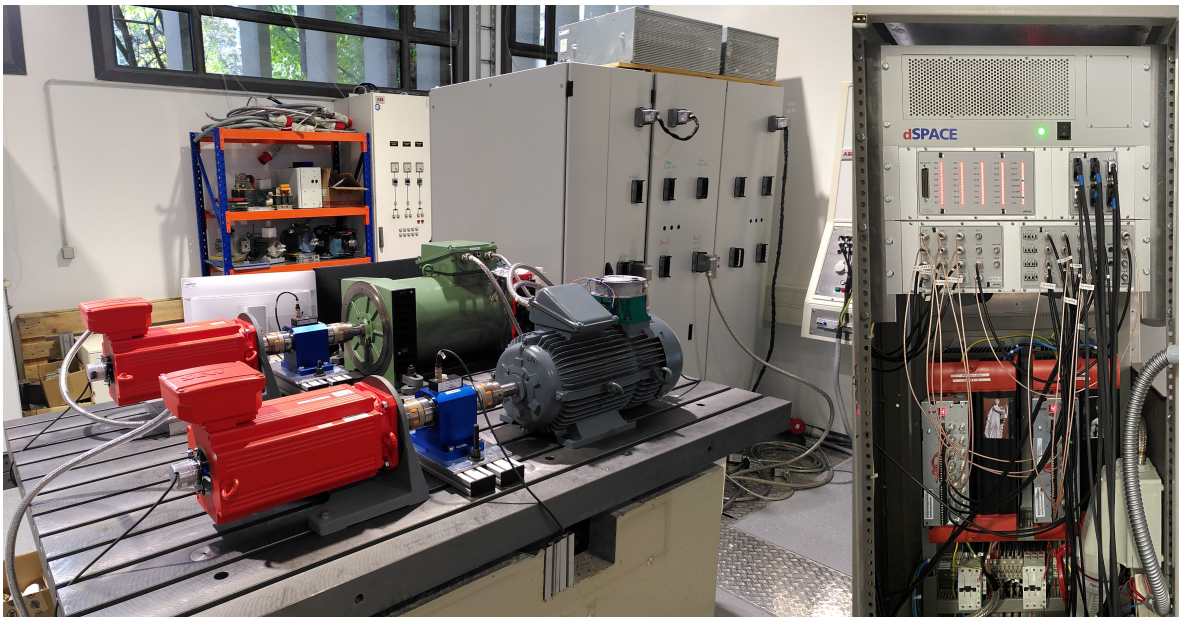
Abbildung 21: Aufbau des maschinenseitigen Prüfstands im LMRES mit Prüfling (DFIM, rechte vordere graue Maschine), Last (PMSM, linke vordere rote Maschine), Drehmomentsensor (mittig, blau) und Schaltschränken (Hintergrund) bzw. mit Ansicht eines geöffneten Schaltschranks (rechts), in dem das Realzeitsystem (dSPACE, oben) und zwei Umrichter (darunter) verbaut sind.
